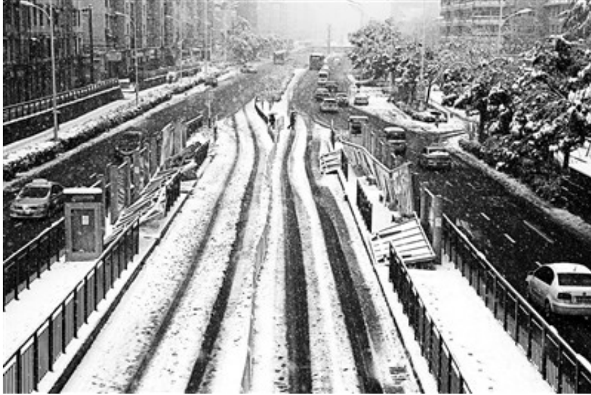
大雪中，合肥市望江路陆续有16处BRT公交站台顶板倒塌供图/视觉中国
